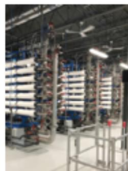
**Système membranaire et membrane:** L'eau est acheminée vers les trains d'ultrafiltration membranaire.
