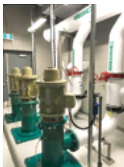
**Pompes d'eau brute:** Les pompes d'eau brute acheminent l'eau vers le bassin de floculation.
