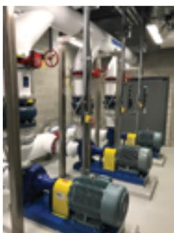
**Pompes des tamis et tamis:** L'eau est pompée à travers le tamis qui retient les particules grossières.
