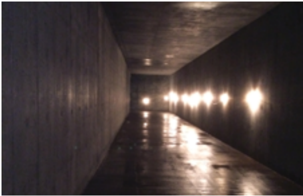
Intérieur du réservoir
