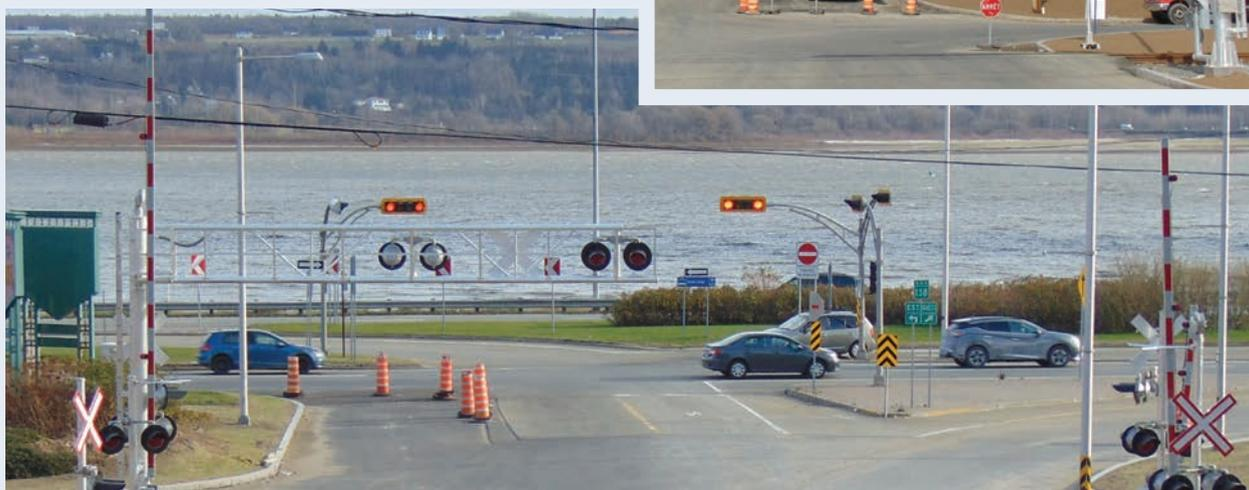
Ajout d'équipements de sécurité ferroviaire au passage à niveau et reconfiguration du parcours de la piste cyclable.
